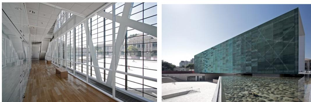
Figura 34: À esquerda, vista interna de corredor expositivo e da entrada de luz. À direita, detalhe do plano de cobre utilizado para a vedação externa.
