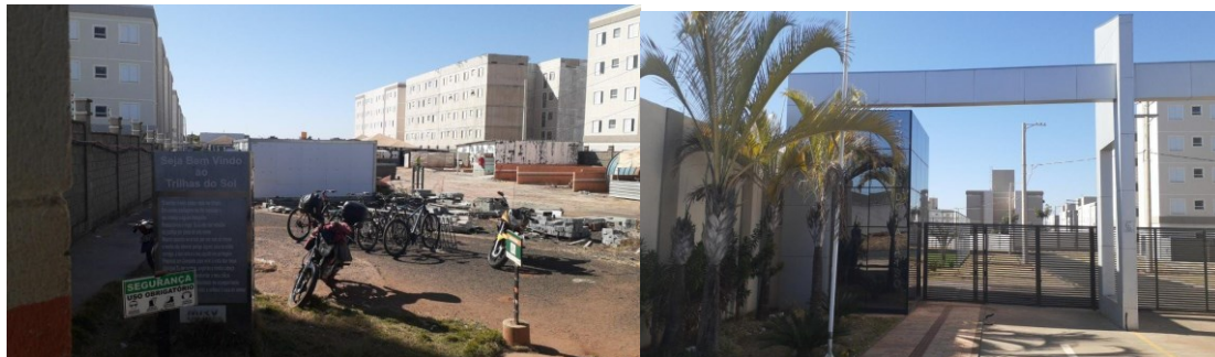
Figura 51 - Espaço interno e fachada principal do edifício Trilhas do Paraíso
