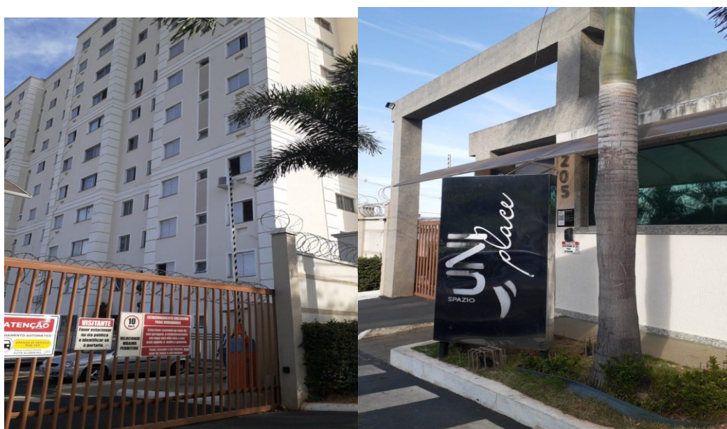
Figura 57 - Entrada e fachada do Parque Uniplace
