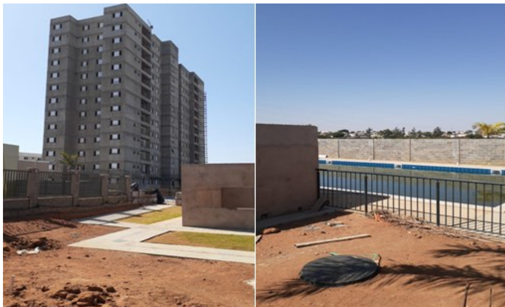
Figura 56 - Entrada e acesso à piscina do empreendimento Univerdi Residence
