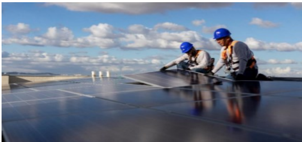
Figura 14 - Implantação de placas solares fotovoltaicas nos empreendimentos da MRV Engenharia
