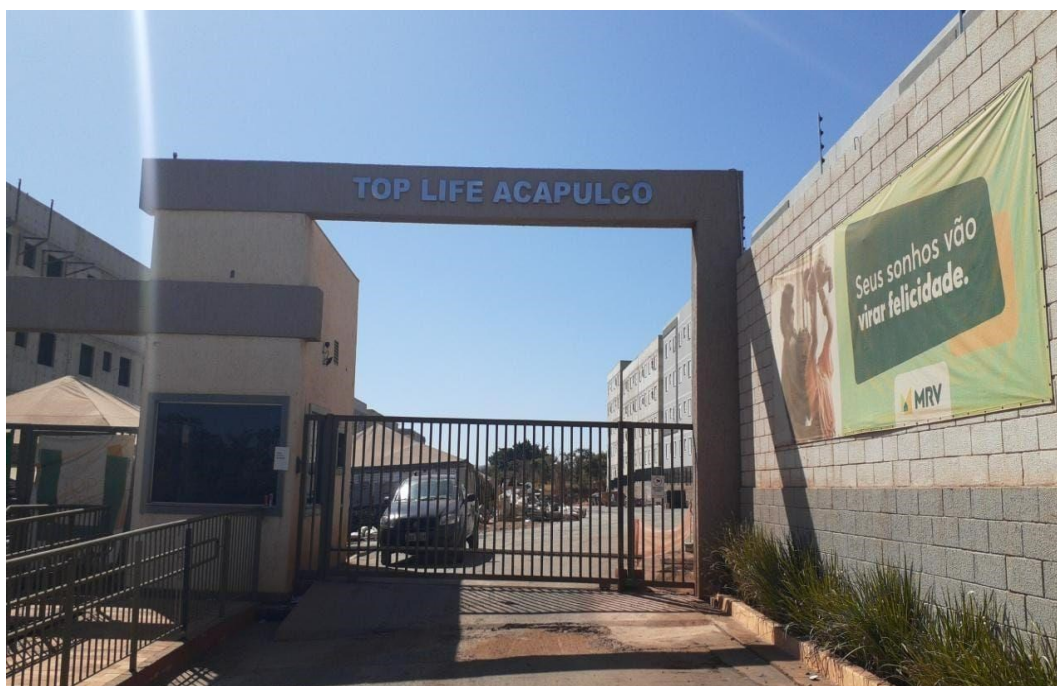
Figura 52 - Entrada do edifício Top Life Acapulco
