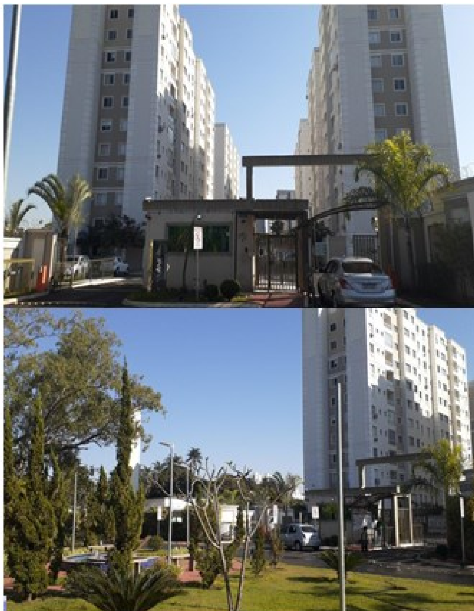
Figura 54 - Entrada do edifício Spazio Unigarden e praça localizada em sua frente
