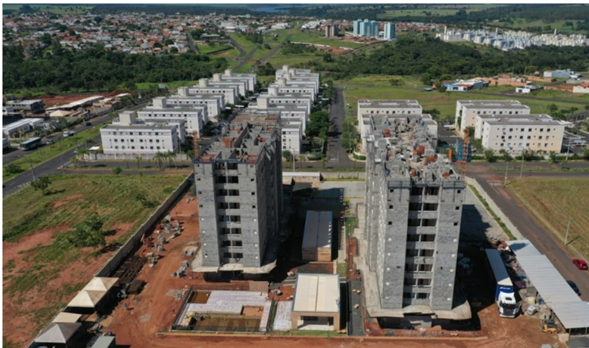
Figura 11 - Empreendimento Origion em construção em Uberlândia/MG
