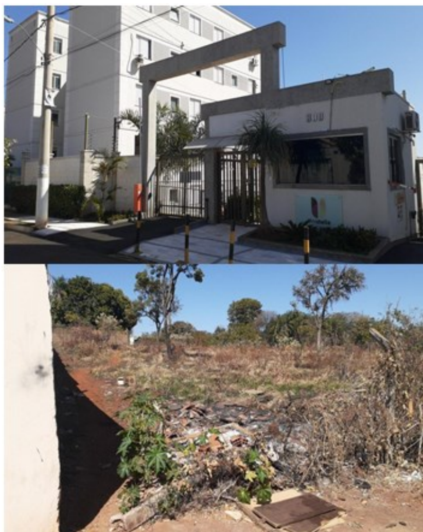
Figura 47 - Fachada principal do edifício Parque Unistella e terreno vazio à sua frente com acúmulo de lixo
