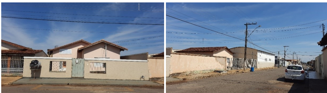
Figura 46 - Fachada CEIM Fonte: registrado pela autora
