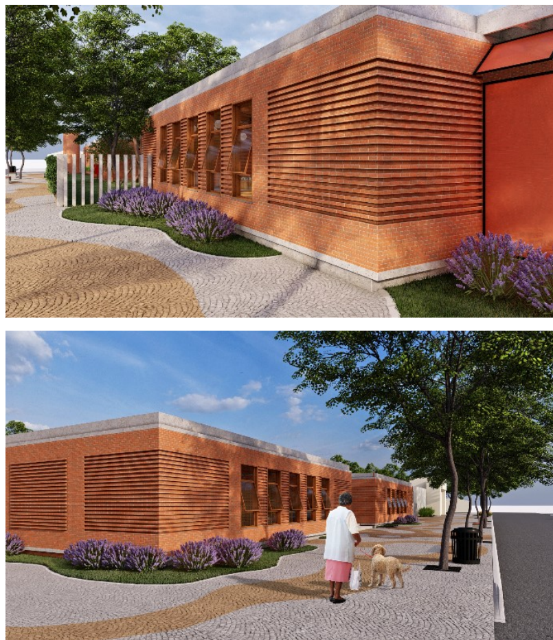
Figura 102 - Vista do assentamento do tijolinho na fachada Fonte: elaborado pela autora
