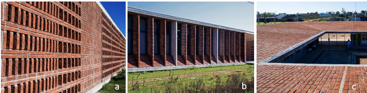
Figura 30 – Escola Integral N300, Colonia, Uruguai – a) fechamento lateral com assentamento dos tijolos permitindo visualização e segurança; b) elementos verticais que fazem a modulação da fachada e se torna uma estratégia bioclimática; c) telhado da escola em tijolo
