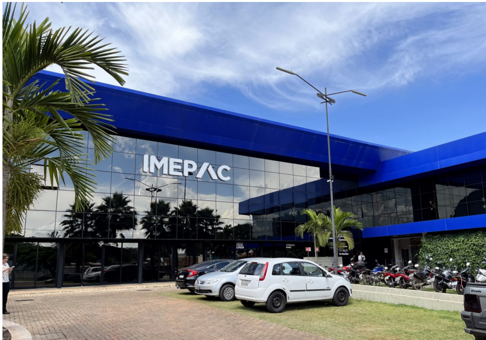
Figura 3.1. Fachada do prédio onde está localizado o Centro de Simulação Médica Realística do IMEPAC em Araguari - MG.
