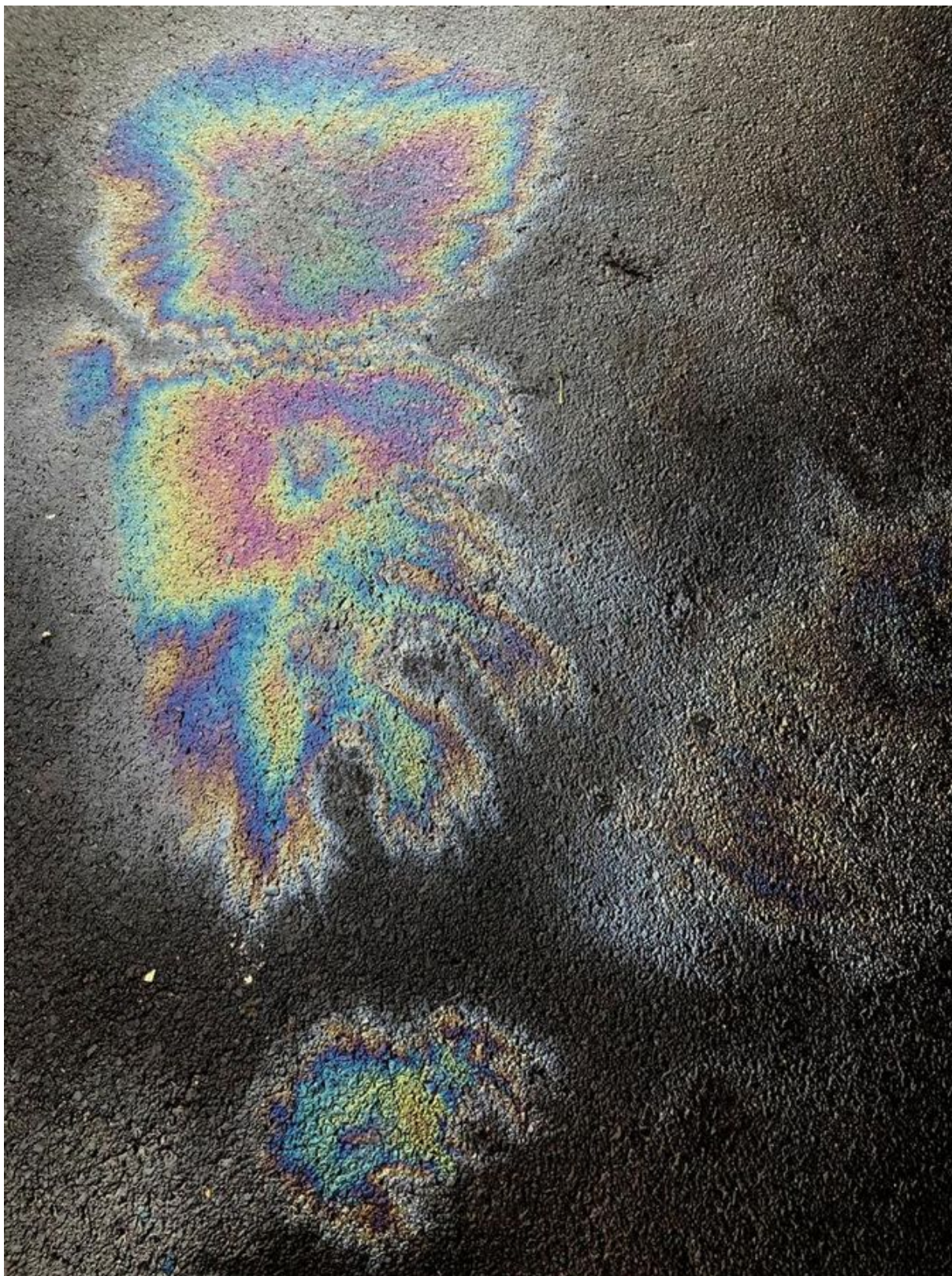
Figura 17 — Mancha de óleo sobre asfalto 4
