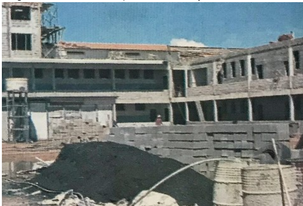
Imagem 14 - Obras de construção do Presídio Jacy de Assis
