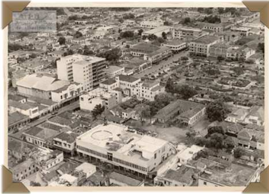
Figura 14 - Vista da Praça Tubal Vilela - Na foto é possível ver a antiga escola Bueno Brandão em frente a praça Tubal Vilela (Antes da Reforma) e o complexo do Uberlândia Clube, que abriga em seu interior o Teatro Rondon Pacheco. [S,d]
