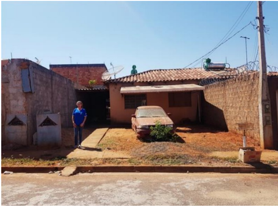
Figura 67 - Fachada Casa Adriana
