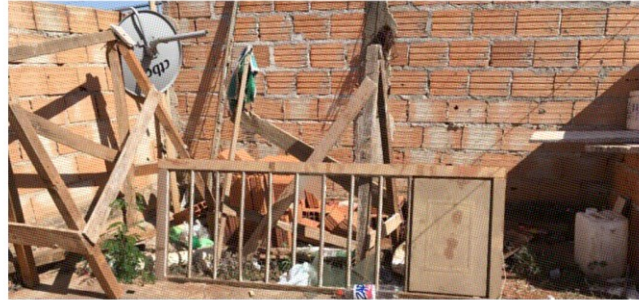
EXEMPLO DE MATERIAIS DE CONSTRUÇÃO E ENTULHOS ARMAZENADO NO FUNDO DO LOTE
