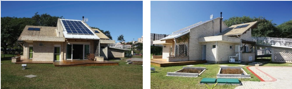
Figura 12 - Vista Nordeste e Noroeste
