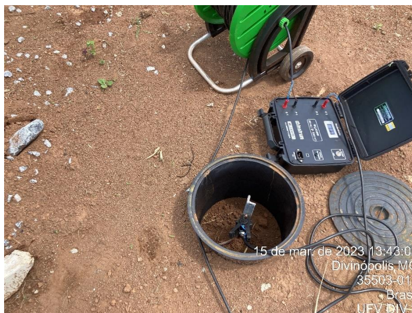
Figura 37 - Medição da haste de aterramento
