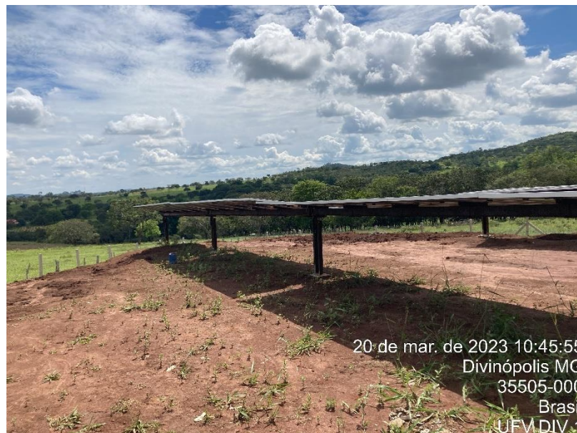
Figura 26 - Módulos desalinhados.
