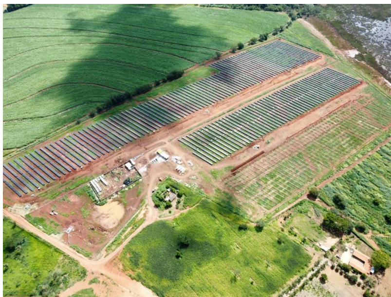
Figura 11 – UFV lagoa da Prata em construção
