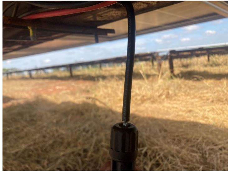
Figura 19 - Conector MC4 do módulo crimpado
