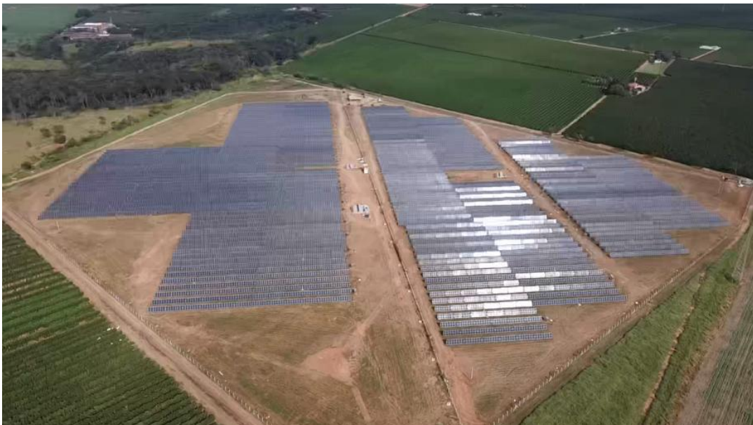
Figura 2 - Usina de energia fotovoltaica minigeração
