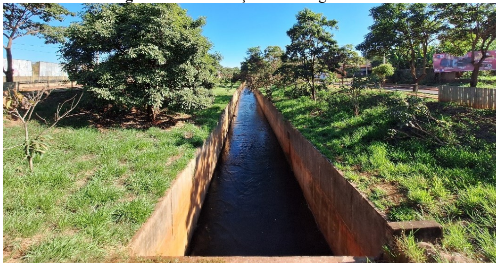
Figura 20: Canalização do córrego São José
