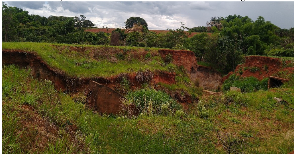
Figura 22: Feição erosiva próxima ao Conjunto Habitacional Nova Ituiutaba I, II, III e IV em forma de voçoroca oriunda da deficiência do sistema de drenagem urbano
