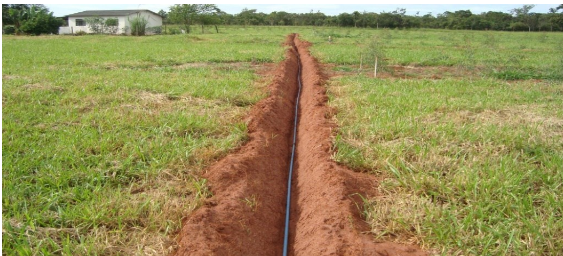
Figura 4. Imagem dos canos utilizados na condução da ARS até a área experimental. (Fonte: Faria, 2015).
