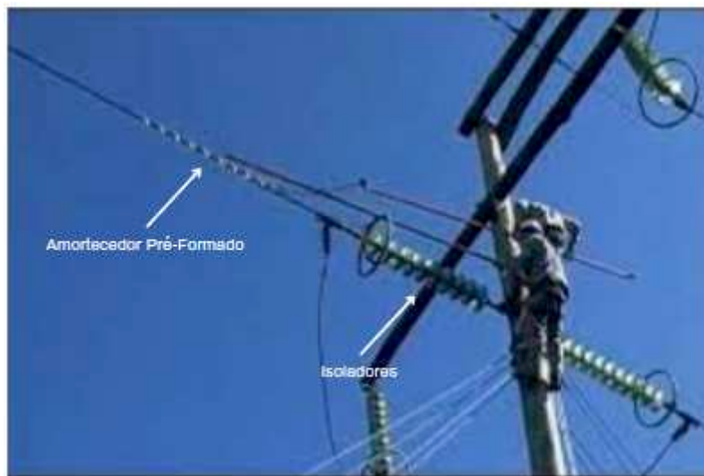
Figura 2: Elementos contidos nos cabos de transmissão.
