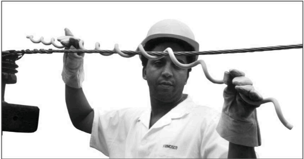
Figura 6: Instalação manual de um amortecedor pré-formado.
