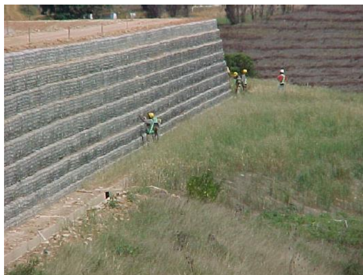
Figura 9 - Vista frontal do aterro reforçado durante os trabalhos de hidrossemeadura.
