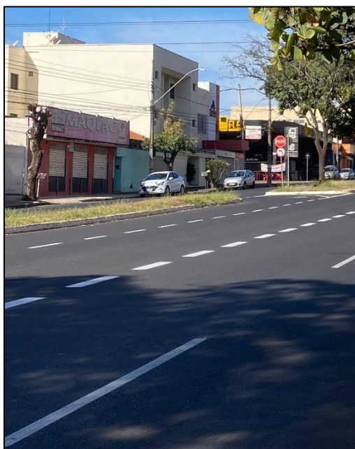
Figura 81: Retorno no trecho 06 (vista leste x oeste)
