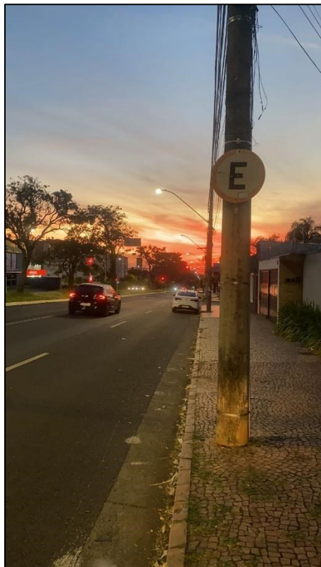
Figura 69: Sinalização Horizontal em desacordo com a sinalização vertical
