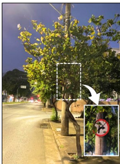
Figura 78: Sinalização vertical encoberta por vegetação no trecho 7 (sentido leste x oeste)
