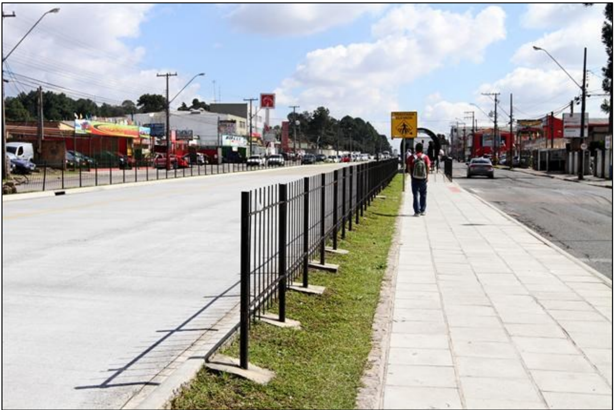
Figura 110: Gradis no canteiro central
