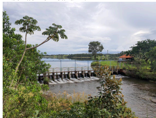
Figura 23 Reservatório de Bom Jardim – Ribeirão Bom Jardim.
