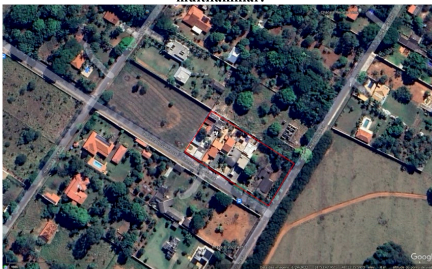
Figura 58 Mansões Aeroporto, lote com taxa de ocupação acima de 20% e habitação multifamiliar.
