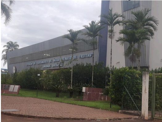
Figura 30 Estação de Tratamento de Água Renato de Freitas, Unidade Sucupira.
