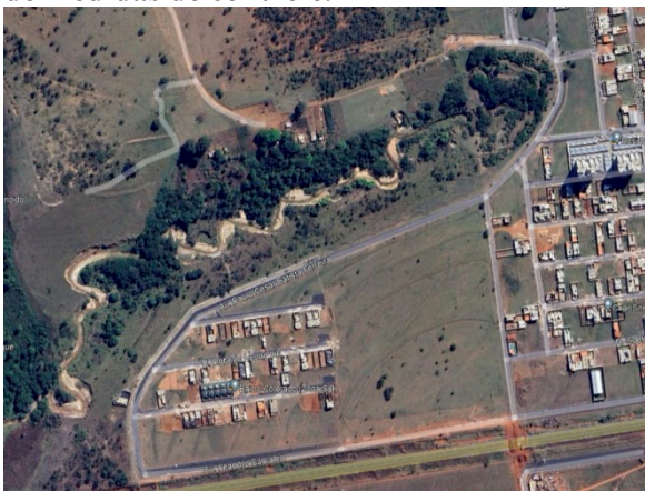
Figura 51 Córrego Campo Alegre, impactos causados pela urbanização do entorno e falta de medidas de controle.
