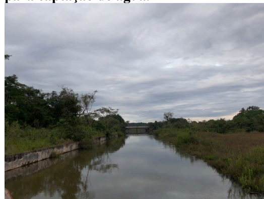
Figura 27 Represamento do rio Uberabinha para captação de água.
