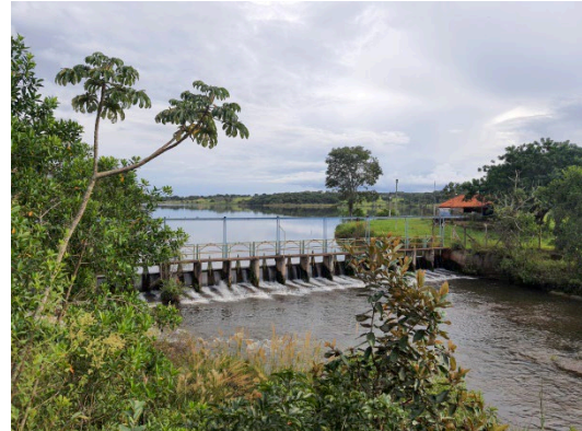
Figura 31 Reservatório de Bom Jardim – Ribeirão Bom Jardim.
