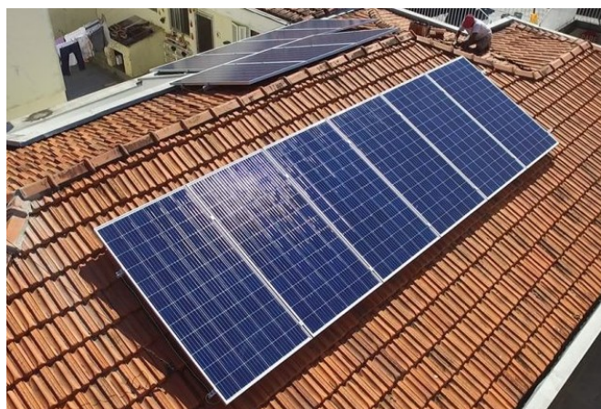
Figura 5 – Instalação de módulos solares em residência brasileira
