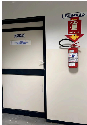
Figura 26 - Extintor de incêndio localizado ao lado da entrada da sala 2B217 da Coordenação de Biomedicina - UFU, bloco 2B, Campus Umuarama da UFU.
