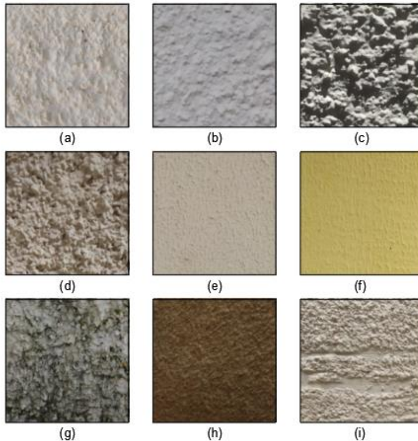
Figura 47 - Texturas do acabamento superficial chapiscado
