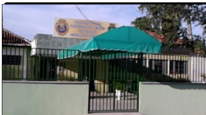
Figura 5. Fachada atual do Colégio Polivalente de Fortaleza.
