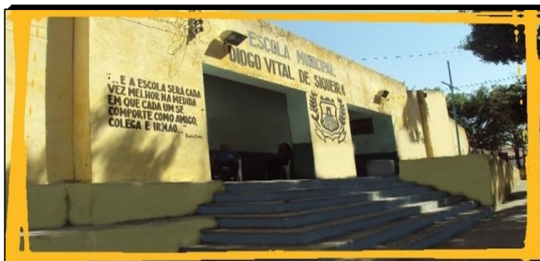
Figura 3. Fachada atual da Escola Municipal Diogo Vital de Siqueira.
