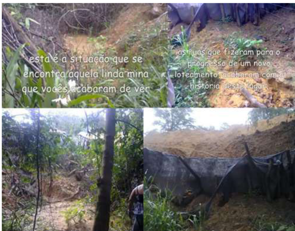
Figura 34: Sequência de imagens da Mata e Mina do Quenta Sol com o início das obras de urbanização no local.
