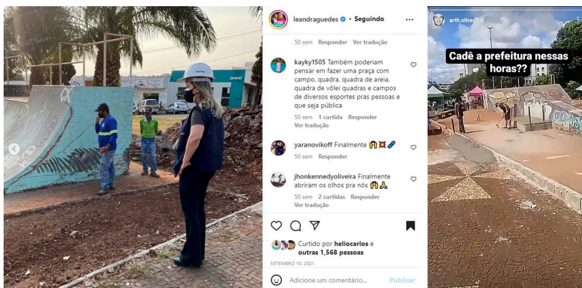
Figura 33: Obra na Praça dos Trabalhadores, interação e intervenção da sociedade local de Ituiutaba
