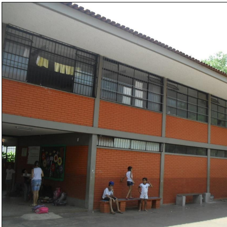
Figura 25 – Prédio próprio da Escola Estadual Ituiutaba
