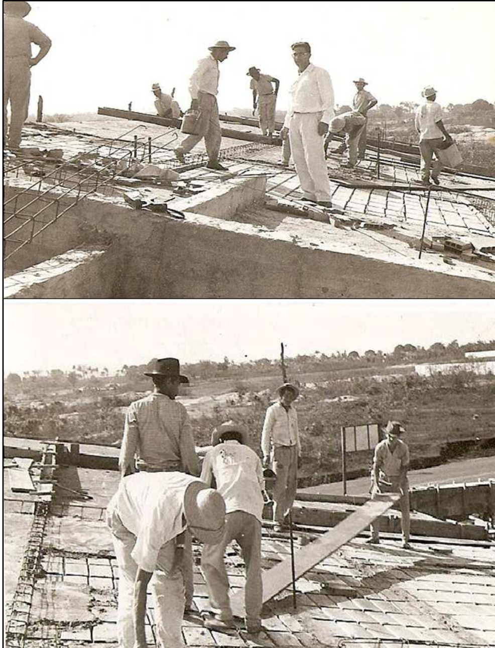
Figura 12 – Etapa de construção do Grupo Escolar Governador Clóvis Salgado
