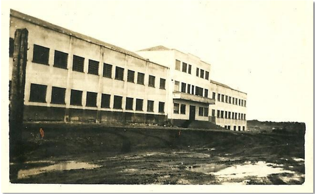
Figura 15 – Fachada do novo prédio do Ginásio São José - 1955
