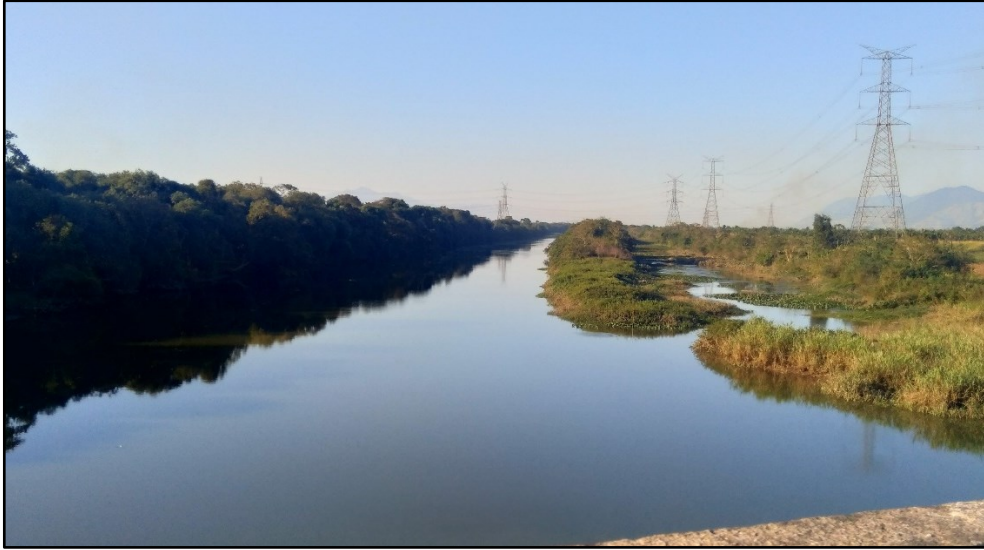
Figura 25 – Leito do Rio Guandu com vista para montante.
