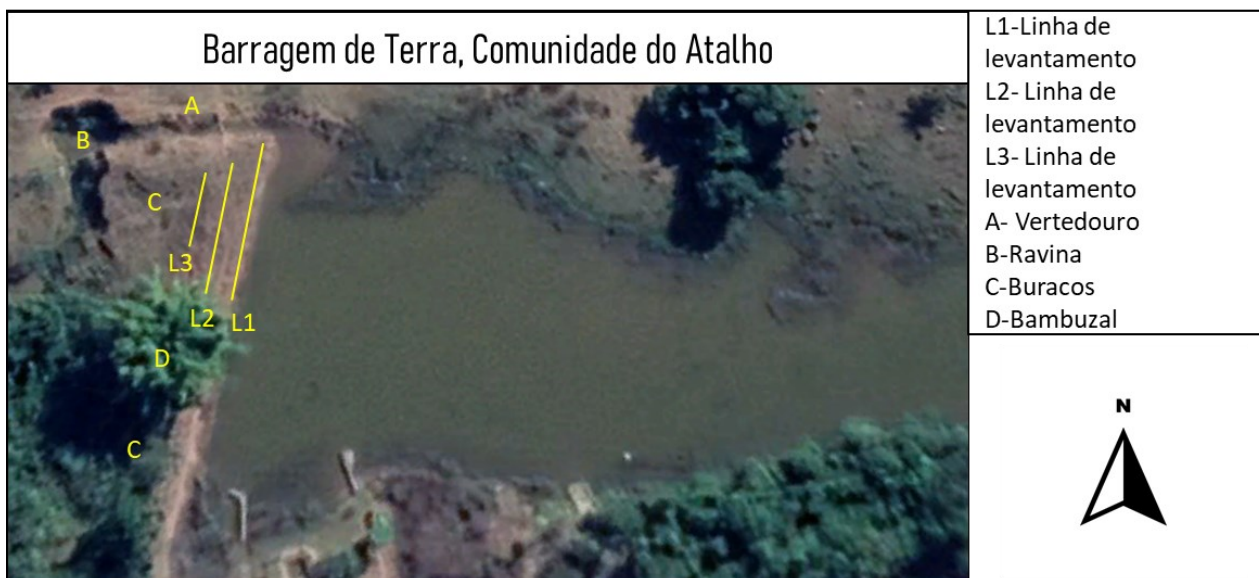
Figura 10. Localização da barragem da comunidade do Atalho com destaque das áreas de atenção. Fonte: autor.
