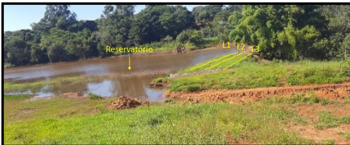
Figura 11. Vista panorâmica da barragem e reservatório de água. Fonte: autor
