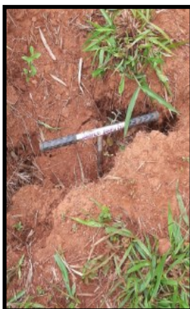
Figura 27. Buraco com quase 1,5 metros de extensão.
