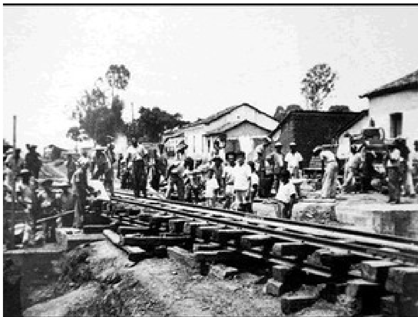
Figura 5: Obras de construção de um viaduto em Montes Claros em 1948.
