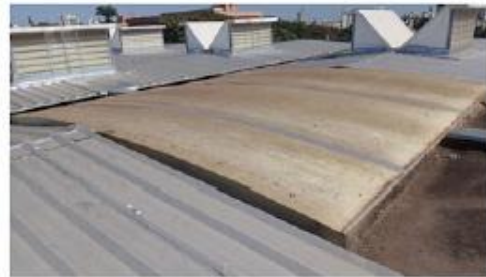
Vista do domus a partir da cobertura da Biblioteca
