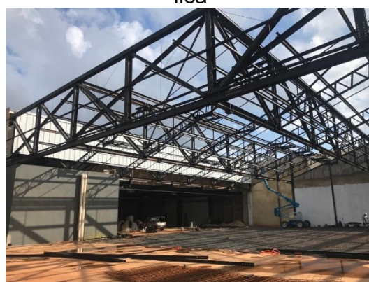
Figura 2 – Galpão em estrutura metálica
