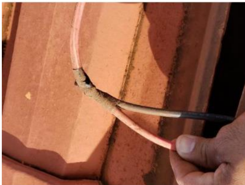
Figura 17: Emendas inadequadas.
