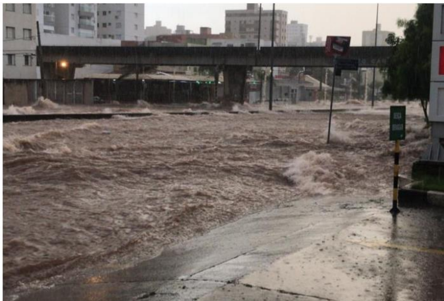
Figura 3.7 – Imagem de inundação na avenida Rondon Pacheco no dia 07/12/2019, nas proximidades do viaduto Carlos Saraiva. Total precipitado de 61 mm de chuva em 2h.
