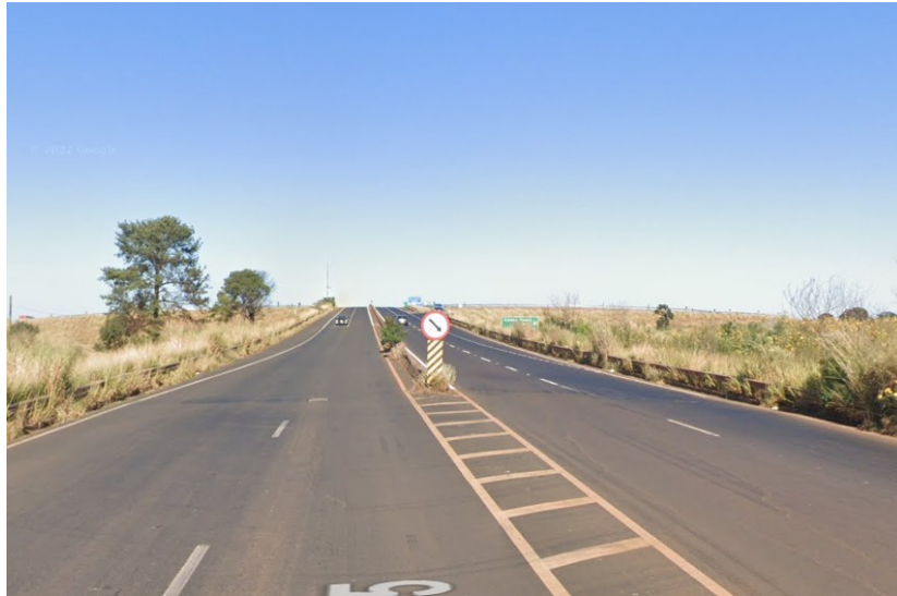
Figura 44 – Parte do Trecho O, em destaque início de pista dupla
