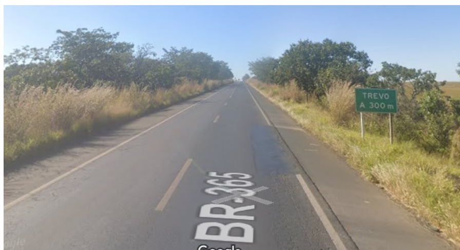
Figura 4 – Parte do Trecho A com sinalização de indicação
