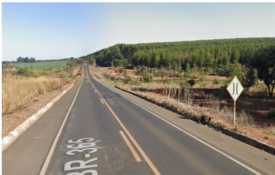
Figura 26 – Parte do Trecho H, em destaque sinalização de ponte estreita
