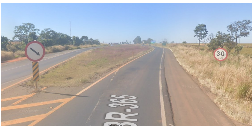
Figura 6 – Parte do Trecho A com sinalização de indicação de velocidade a 30km/h
