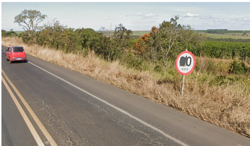
Figura 30 – Parte do Trecho I, em destaque sinalização de regulamentação deprecada
