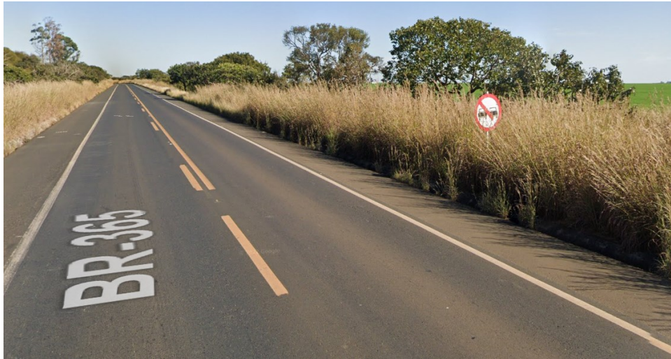
Figura 8 – Parte do Trecho B com placa de regulamentação de proibido ultrapassagem
