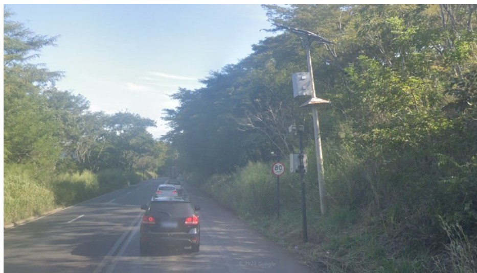
Figura 35 – Parte do Trecho K, em destaque o dispositivo de fiscalização eletrônica
