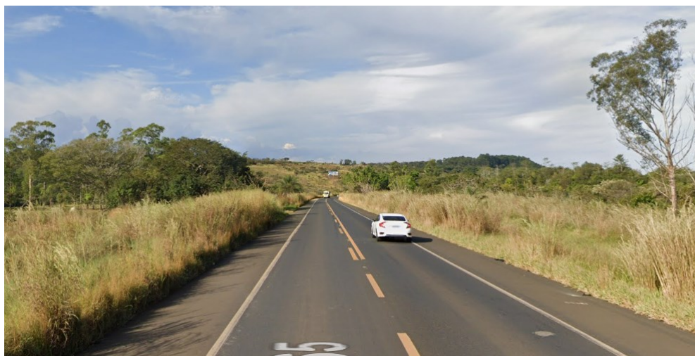
Figura 10 – Parte do Trecho C sem sinalização vertical de regulamentação de proibido ultrapassagem
