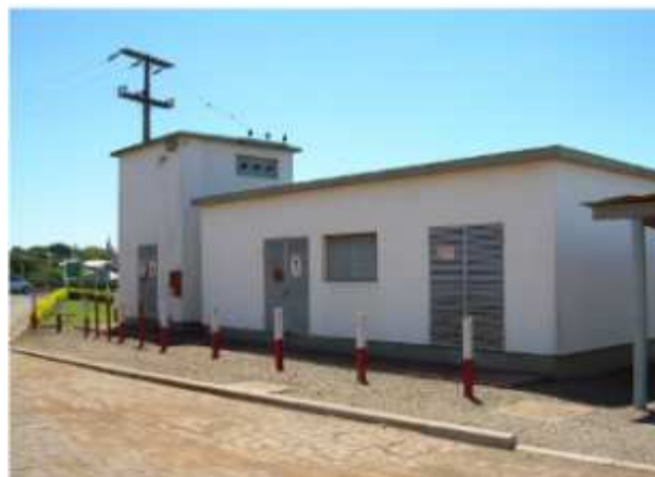
Figura 2 – Subestação abrigada em estrutura de alvenaria
