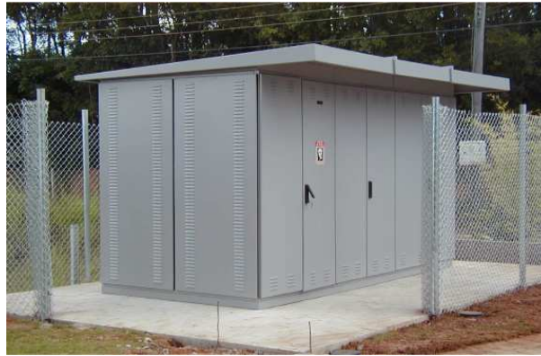
Figura 5 – Subestação blindada
