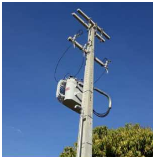
Figura 4 – Subestação aérea
