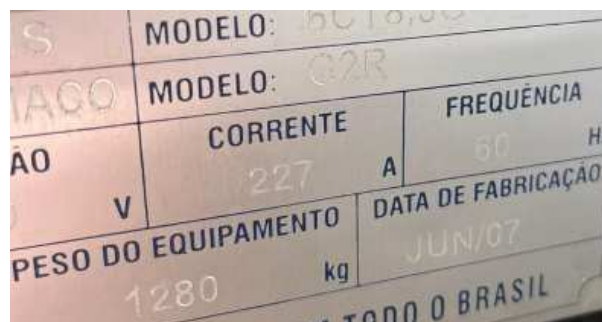
Figura 22 – Dados de placa do gerador
