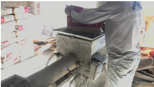
Figura 6: Abastecimento com argamassa na argamassadeira
