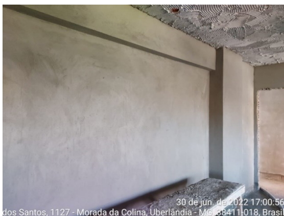
Figura 7: Resultado do reboco projetado
