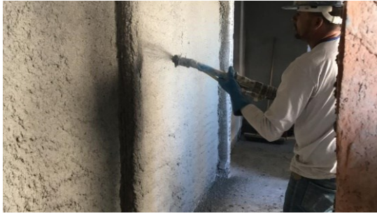
Figura 5: Aplicação de argamassa projetada
