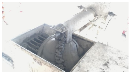
Figura 4: Argamassadeira depositando argamassa na projetora
