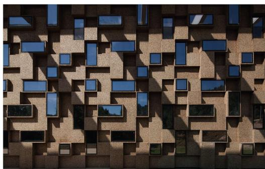
Figuras 56 e 57: Fachadas com módulos de cortiça e painéis de vidro. Fonte: *ArchDaily*
