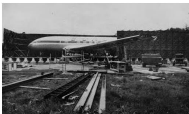
Figura 8 - Construção do tanque de água ao redor da fuselagem do Comet G-ALYU para os testes de ciclo pressurização/despressurização. ( lessonslearned.faa.gov )
