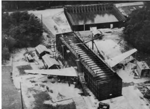
Figura 9 - Fuselagem do Comet G-ALYU imersa no tanque de água para os testes de ciclo pressurização/despressurização. ( lessonslearned.faa.gov )
