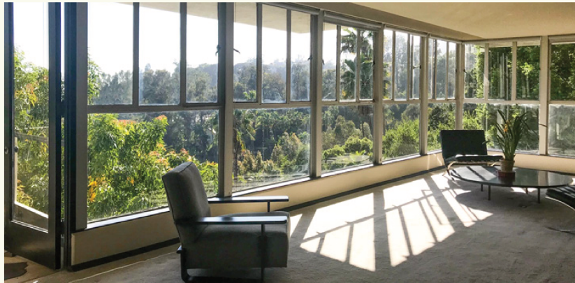
Figura 11: Janela em fita, proporciona forte relação com o exterior e permite iluminação natural no interior.
