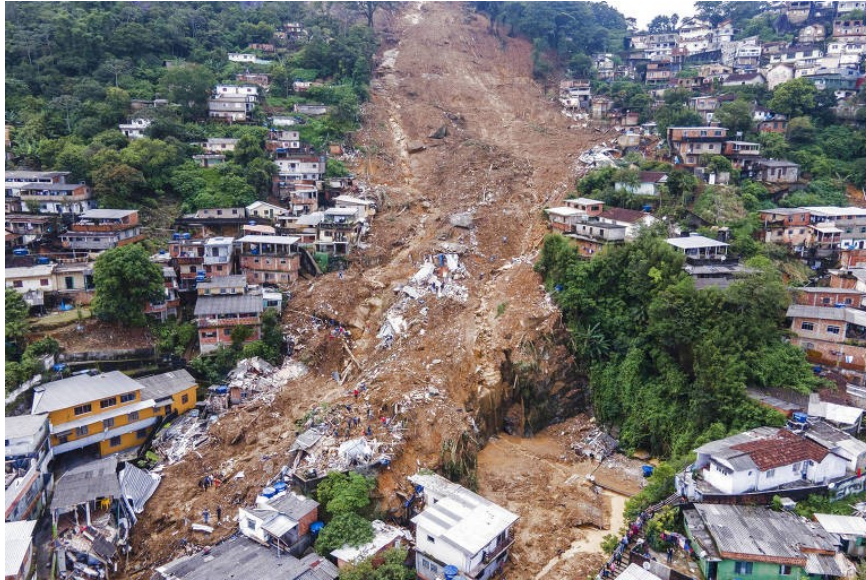
Figura 8 – Cenário pós deslizamento em Petrópolis em fevereiro de 2022.
