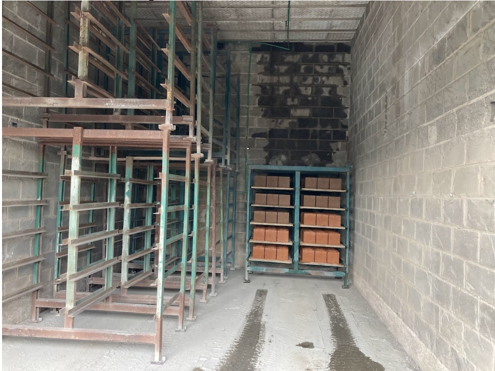
Figura 8 - Cura dos blocos de concreto
