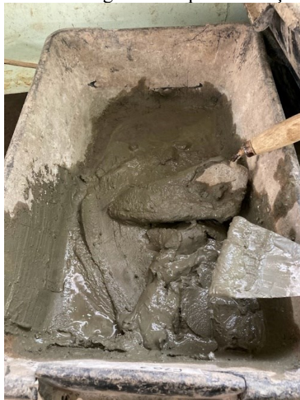
Figura 17 - Pasta de cimento CPV e água usada para execução de capeamento de blocos
