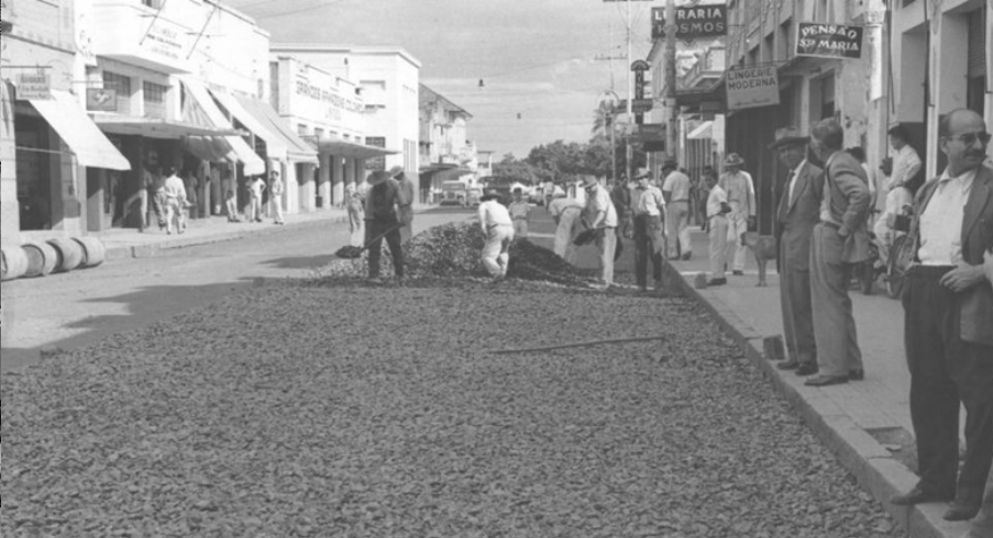
10. Asfaltamento da Avenida Afonso Pena em 1956 em trecho próximo à Rua Bernardo Guimarães. Fonte: Arquivo Público Prefeitura de Uberlândia
