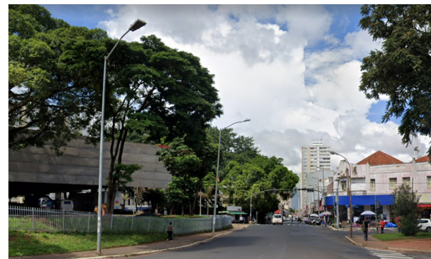
63. Postes de iluminação com infraestrutura elétrica subterrânea. Fonte: Google Earth.
