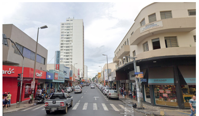
38. Predominância edifícios de 1 e 2 pavimentos. Fonte: Google Earth.
