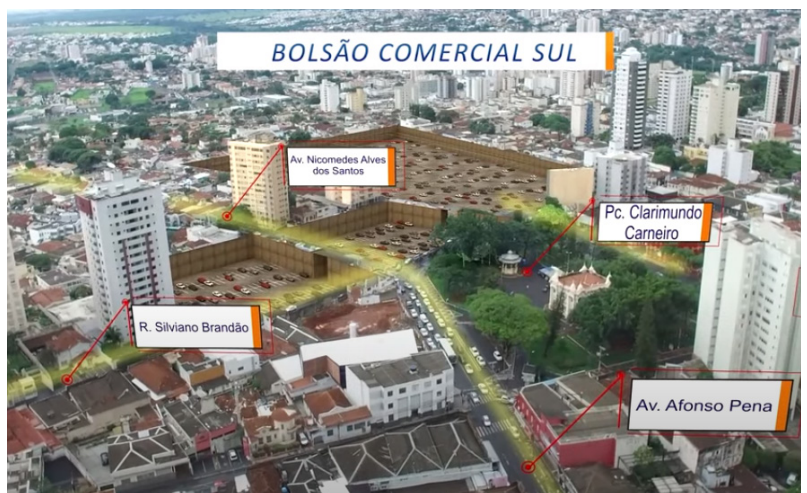
29. Estacionamento subterrâneo no Bolsão Comercial Sul. Fonte: CDL, 2020.
