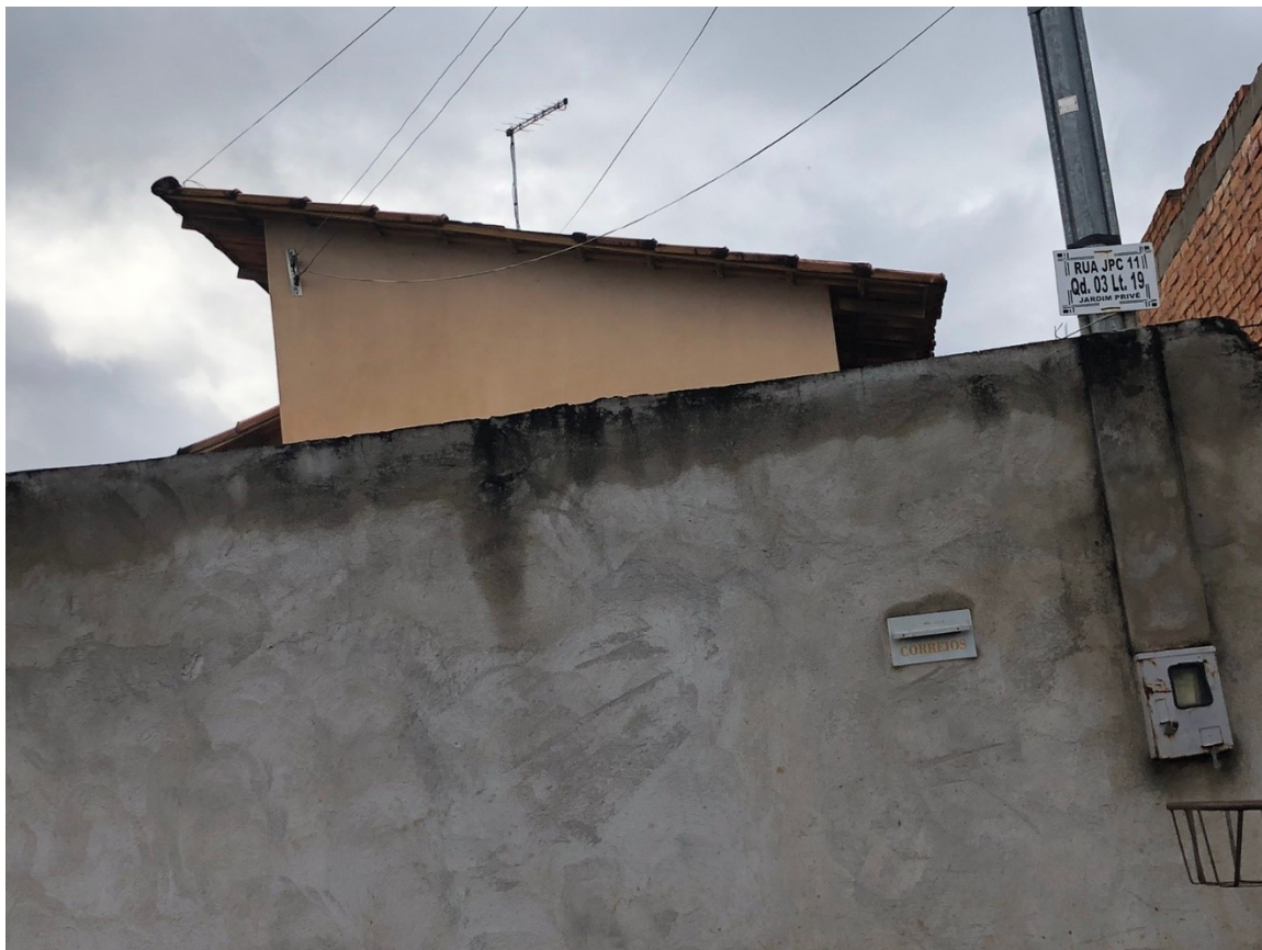
Figura 8: Imóveis localizados na Rua J.P.C 11
