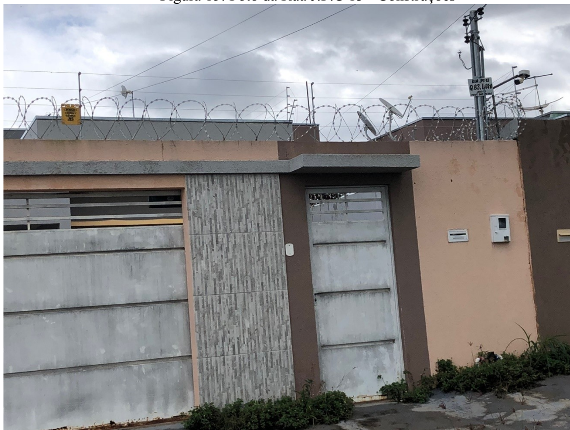
Figura 15: Foto da Rua J.P.C 13 - Construções
