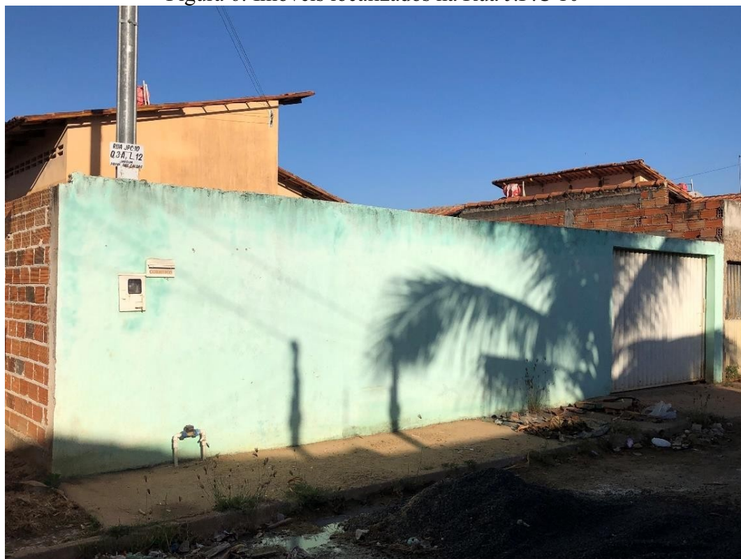
Figura 6: Imóveis localizados na Rua J.P.C 10
