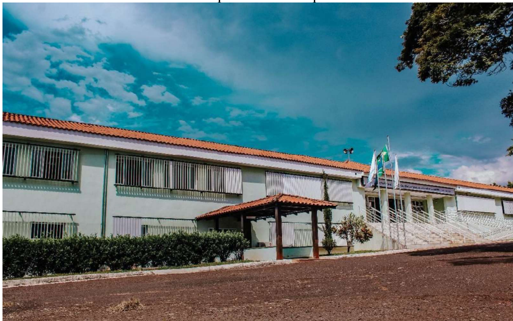
Figura 1- Foto da fachada frontal do prédio do Campus IFTM Uberlândia
