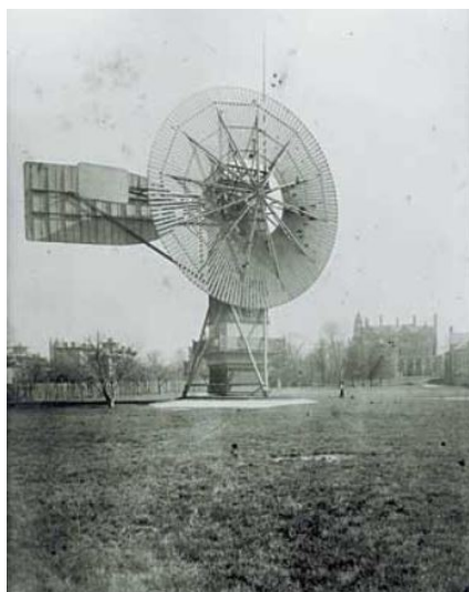
(a) Turbina éolica de Charles Brush (KROUSE, 2011).
