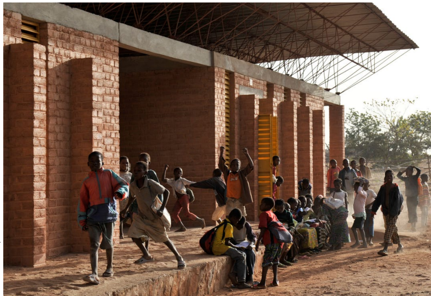
Escola primária em Gando. Siméon Duchoud, Erik-Jan Ouwerkerk, 2001.
