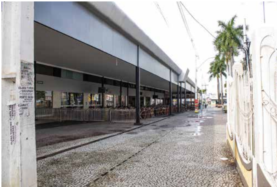
Figura 74: Trecho entre a paróquia e os restaurantes. Fonte: Imagem do Autor.
