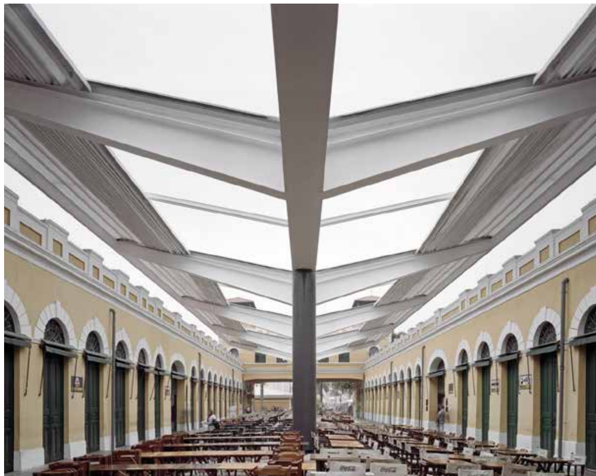
Figura 65: Cobertura sendo retirada. Fonte: Archidaily.
