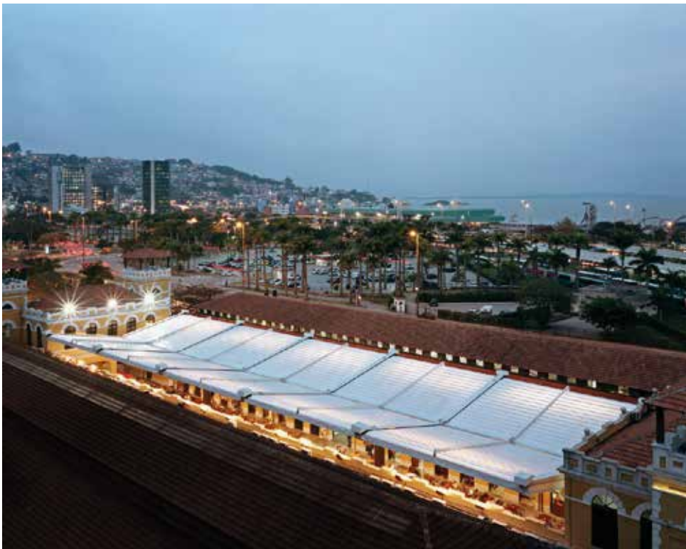
Figura 62: Vista aérea da Cobertura do Mercado Público de Florianópolis. Fonte: Archidaily.
