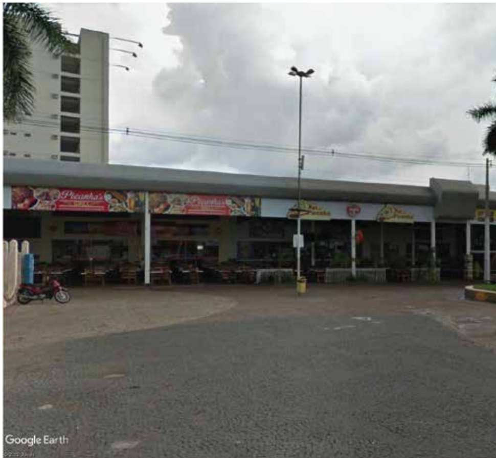
Figura 70: Poste de condução de energia com fiação aérea e postes de iluminação com fiação subterrânea. Fonte: Google Earth.
