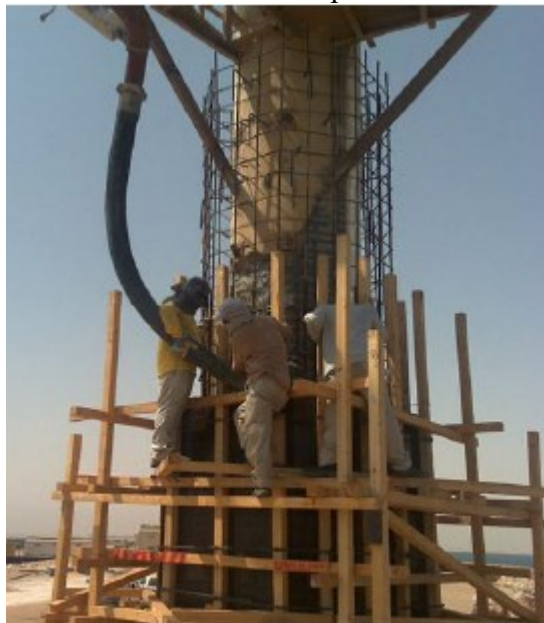
Figura 7: Encamisamento de um pilar em concreto armado
