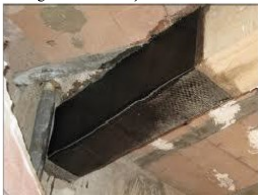
Figura 10: Reforço confinamento
