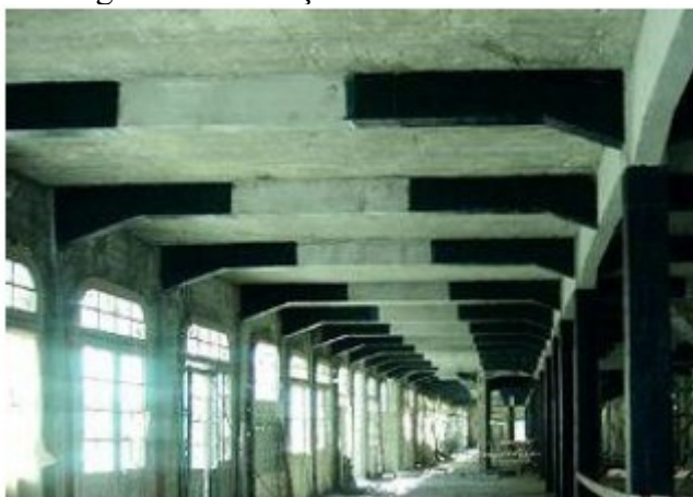
Figura 11: Reforço confinamento
