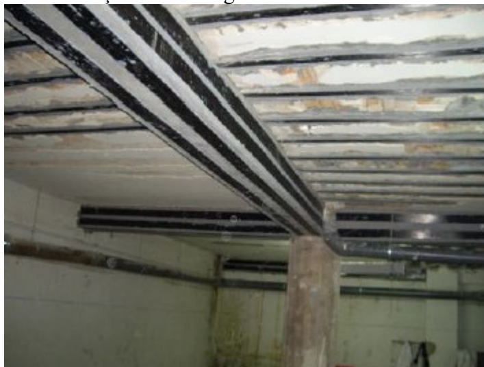
Figura 9: Reforço de umas vigas à flexão com fibras de carbono
