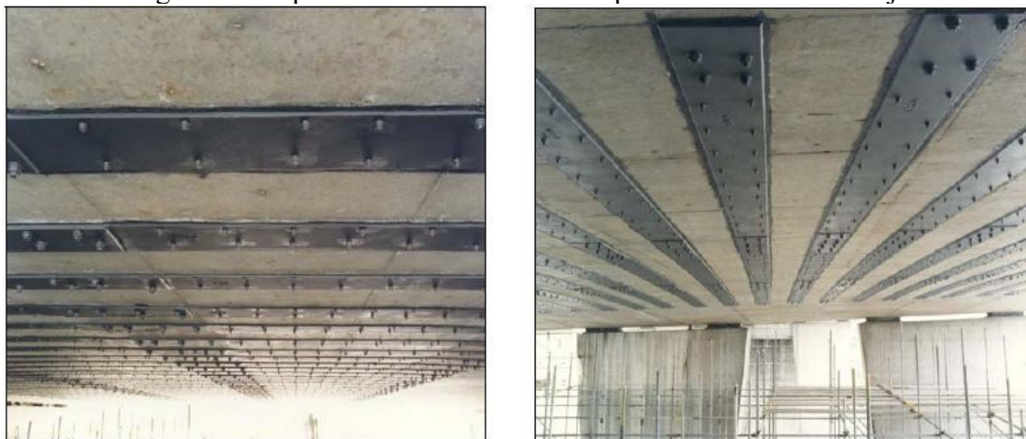
Figura 8: Chapas metálicas colocadas na parte inferior de uma laje
