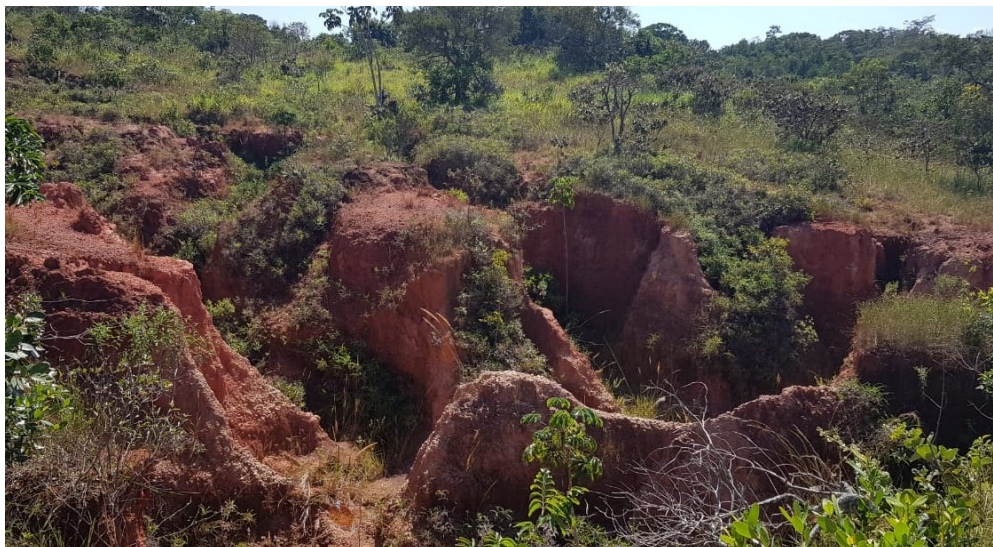
Figura 4 – Imagem atual da voçoroca.
