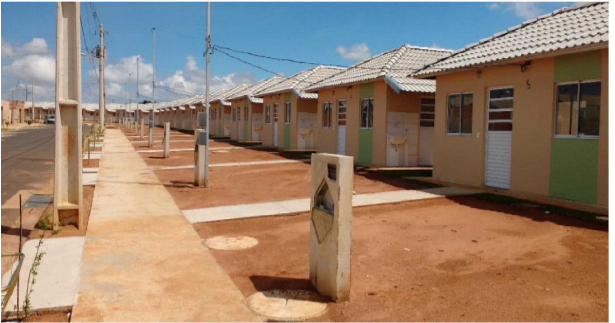
Imagem 2: Residências entregues pelo PMCMV. Fonte: https://www.selisbrandao.com.br/pequis/caracteristicas-do-bairro-pequis/
