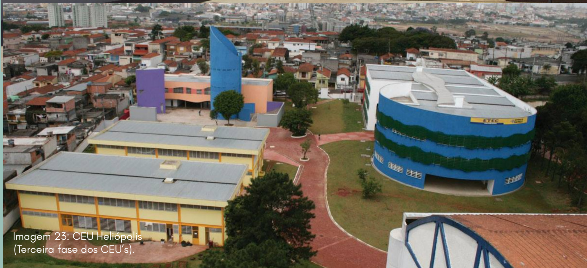
Imagem 22: CEU Lajeado (Segunda fase dos CEU's).
