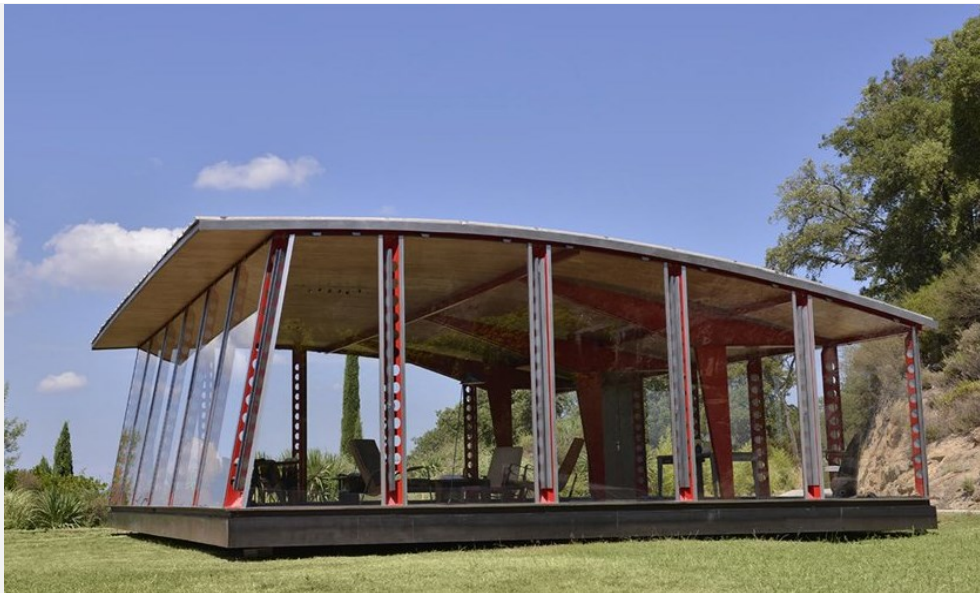
Figura 11 – Sala de aula do Complexo Escolar em Villejuif
