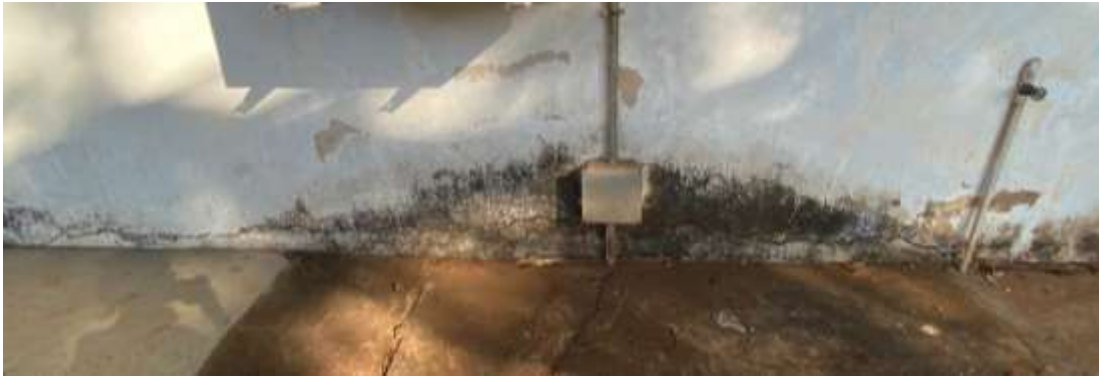
Figura 18 - Extensão da trinca na parede analisada.
