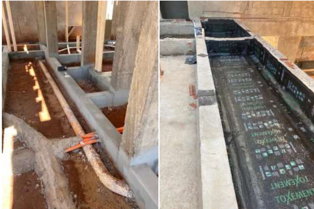
Figura 8 - Exemplo de impermeabilização rígida e flexível aplicada.
