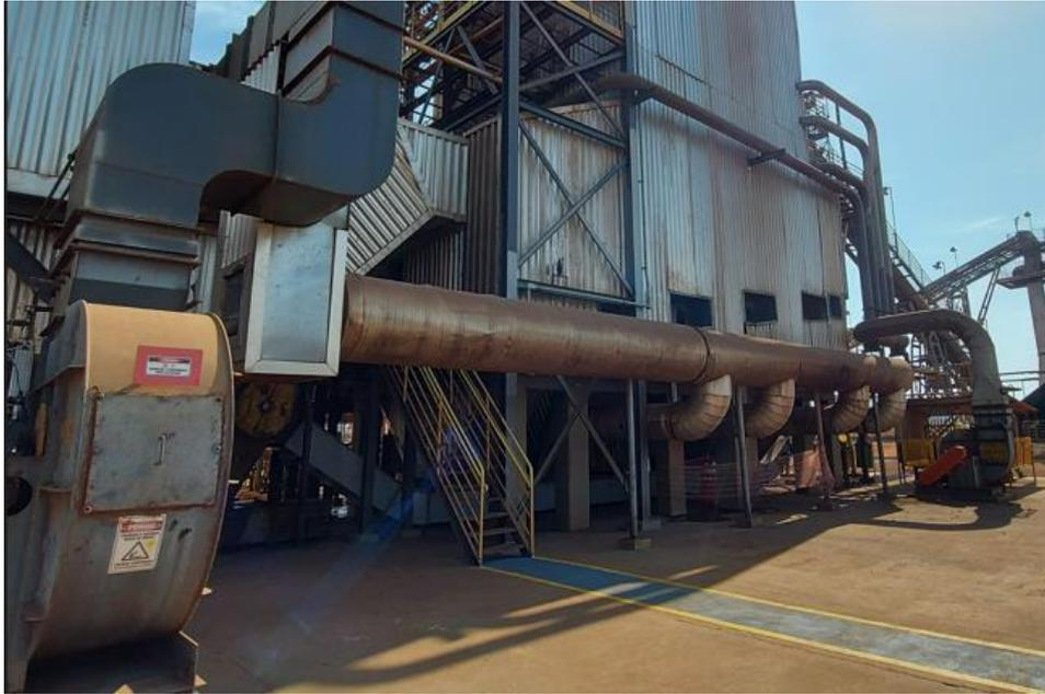
Figura 12: Ventilador primário (à esquerda) e ventilador secundário (à direita)
